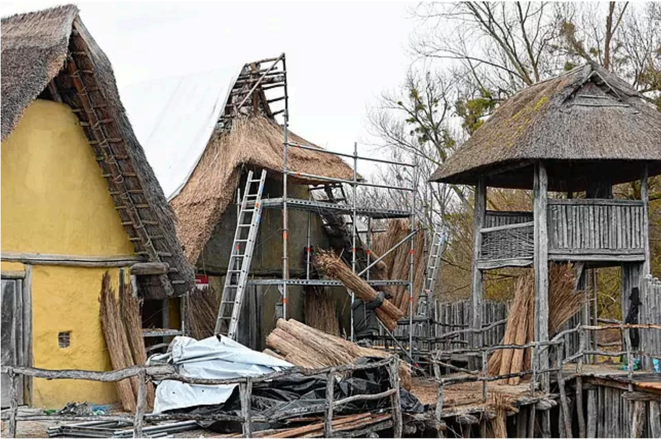
Im März 2025 wird an einem der Dächer gearbeitet. Es muss neu eingedeckt werden. Dafür stehen 2300 Bündel Reet zur Verfügung, die von Volker Barfuß und seinem Team auf etwa 170 Quadratmeter Dach aufbracht werden. | Bild: Rasmus Peters
