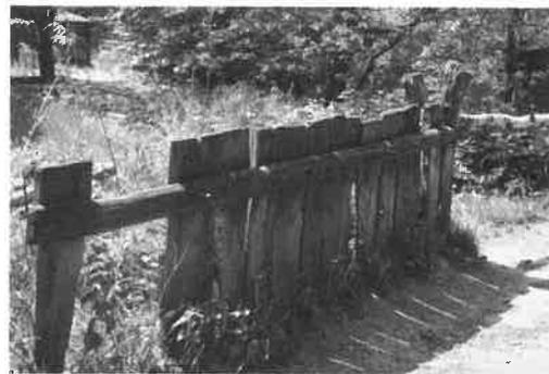
Abb. 4: Spaltbohlenwand mit Endfette und Holznägeln - muß noch mit Lehm abgedichtet werden.
