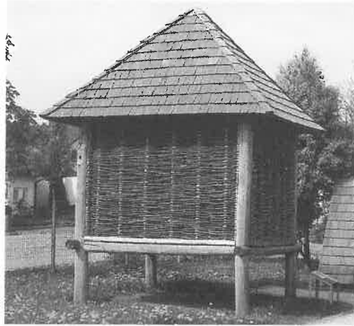
Abb. 24: Der aufgebaute Speicher.
