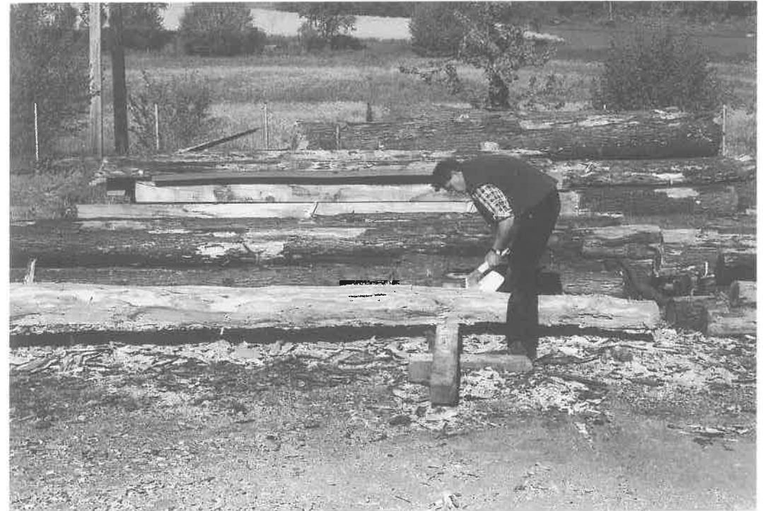
Abb. 7: Entrinden und Entsplinten der Holzstämmе.
