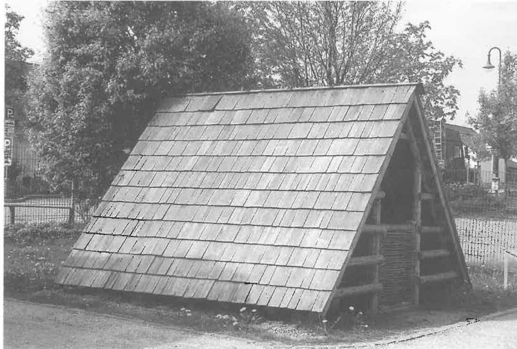
Abb. 27: Der fertig gestellte Erdkeller.
