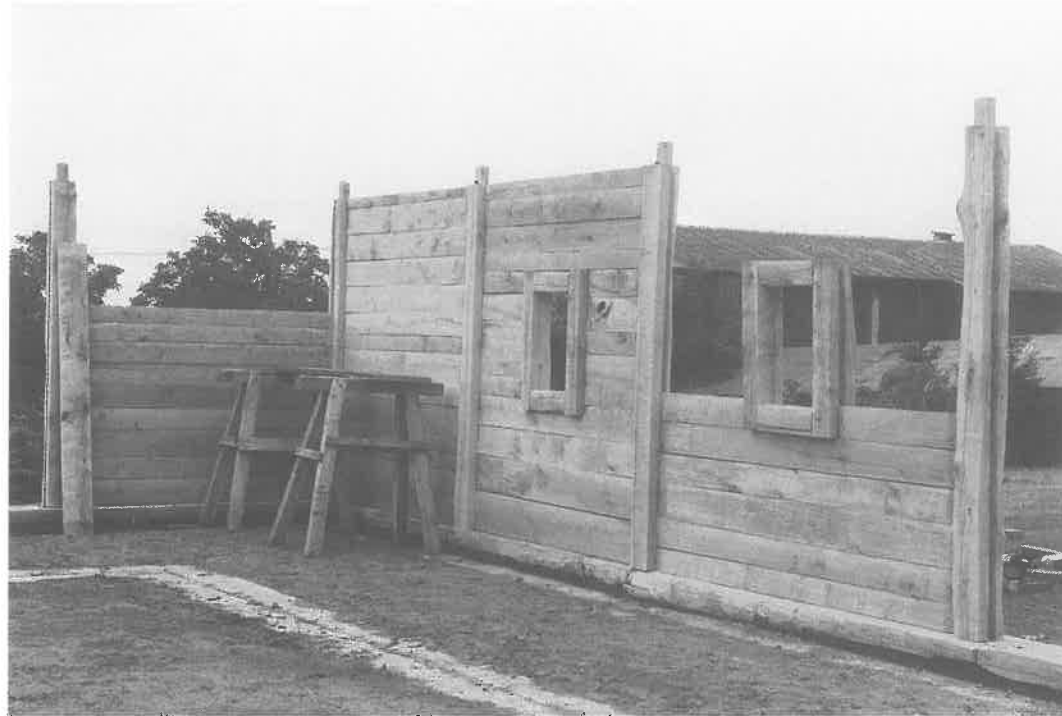
Abb. 10: Die Wände wurden aus Ständern und Bohlen aufgebaut.
