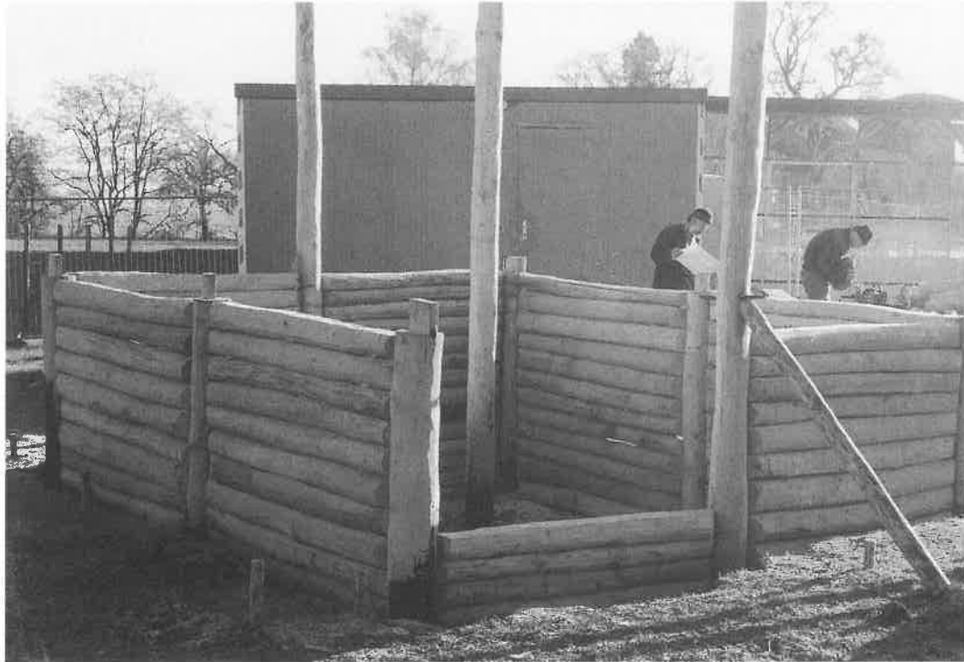
Abb. 19: Das Grubenhaus im Aufbau.
