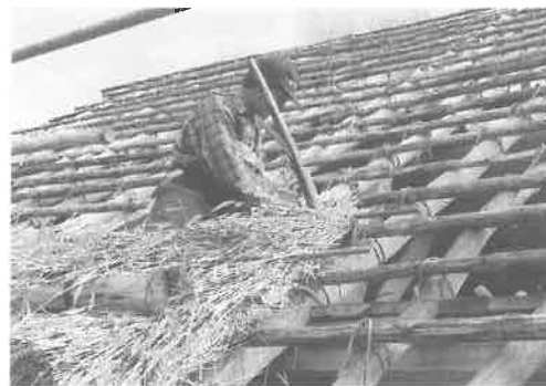
Abb. 13: Die Strohdeckungstechnik.
