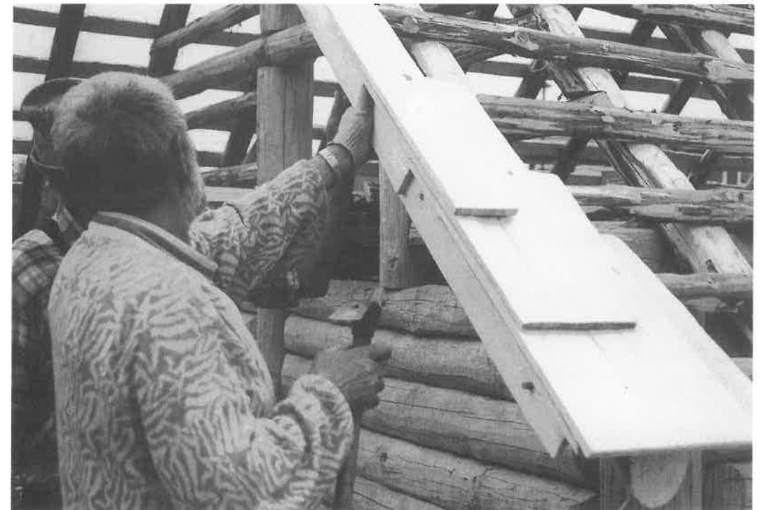
Abb. 21: Die zweieinhalblagige Deckung der Schindel durch Überblatten.
