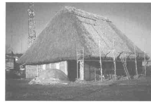
Abb. 14: Das fertig gestellte Haus am 28.11.1998.
