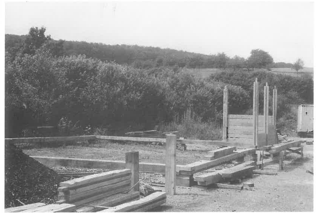
Abb. 9: Probeaufbau im Bauhof.
