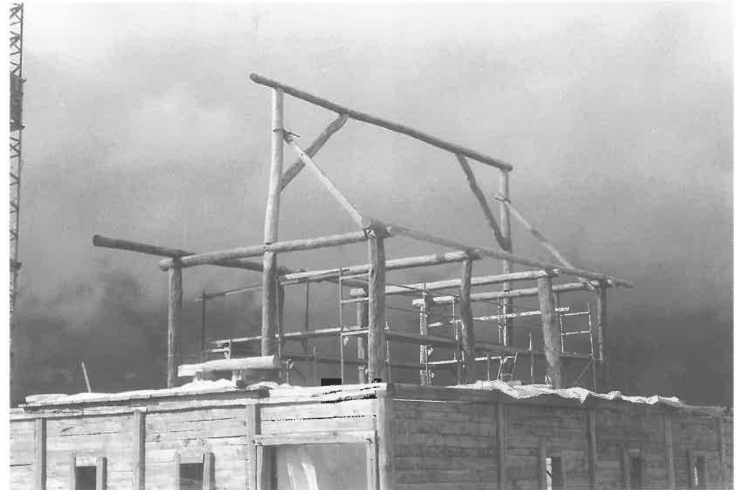
Abb. 11: Die Innenpfosten wurden als Joche zusammengebaut.
