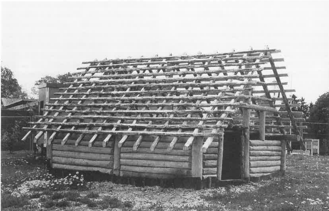
Abb. 20: Das Grubenhaus ist bereit für das Richtfest.
