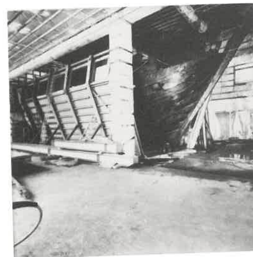
Abb. 7: Bau des Konservierungsbeckens für die Kogge.
