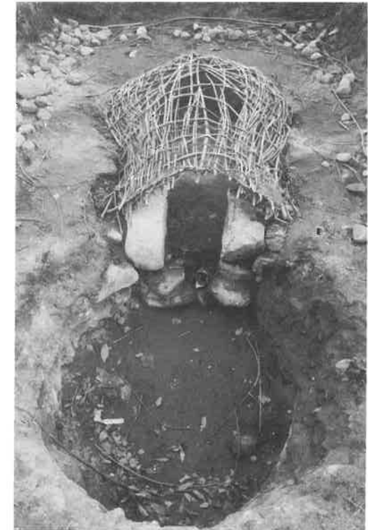
Abb. 2: Töpferofen von Kukate: Freitragende Kuppel aus Weidengeflecht, Beschickungsöffnung und Arbeitsgrube.
