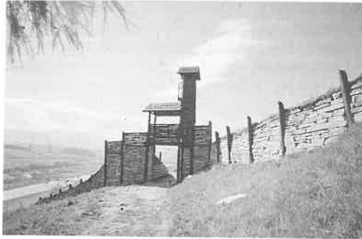
Abb. 2: Die rekonstruierte Toranlage der inneren Befestigung.
