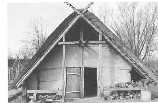
Abb. 11: Das Nebengebäude der Schmiede ist fertig.
