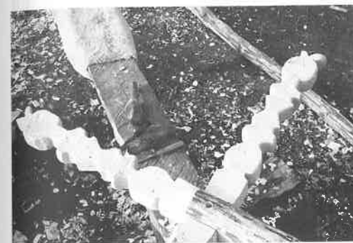
Abb. 10: Das erste Paar Dachsparren haben wir oben bearbeitet, nach dem Vorbild eines in Oss-Ussen (Niederlande) gefundenen Holzstückes.
