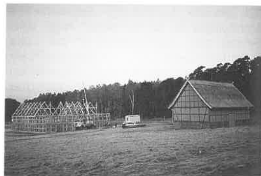
Abb. 4: Aufrichten des Fachwerkes am Dreiseitenhof. Foto: J. Sauer
