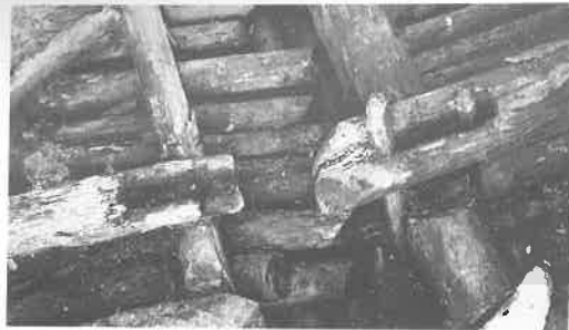
Abb. 5: Eckverbände durch Jochfüzung.
