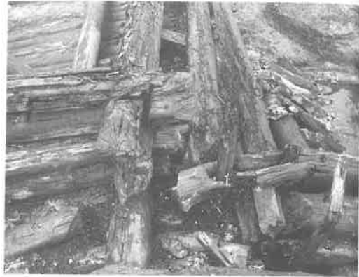
Abb. 6: Eckverbände durch Verkämmung (links) und Jochfüzung (rechts).
