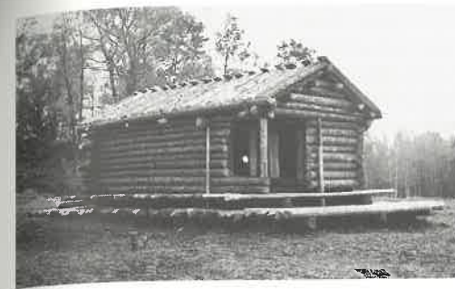
Abb. 10: Das 1981 gebaute experimentelle Gebäude (Nr. 113) der Rekonstruktion.
