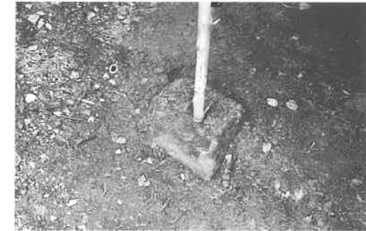
Abb. 20: Der Auflagestein für die Mittelstange fungiert als Widerlager und verhindert das Versinken in den Untergrund (Foto E.G.)
