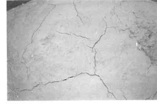
Abb. 9: Trockenrisse auf der ungebrannten Ofenkuppel.
