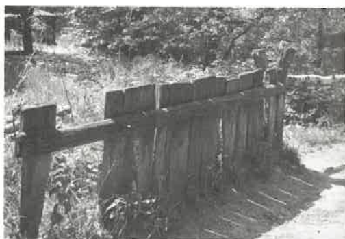
Abb. 4: Spaltbohlenwand mit Endfette und Holznägeln - muß noch mit Lehm abgedichtet werden.
