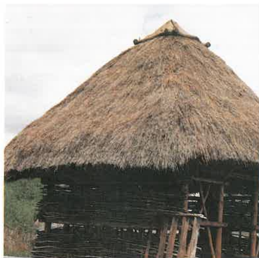
Abb. 2: Speicher, mit Roggenstroh gedeckt und gebunden. Dachfirst mit Lehm mantel.
