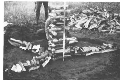
Abb. 1: Bau des Meilers EM 1. Quandelschacht und Belüftungskanäle.
