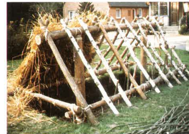
Abb.4: Das Haus mit zum Teil gedecktem Dach.
