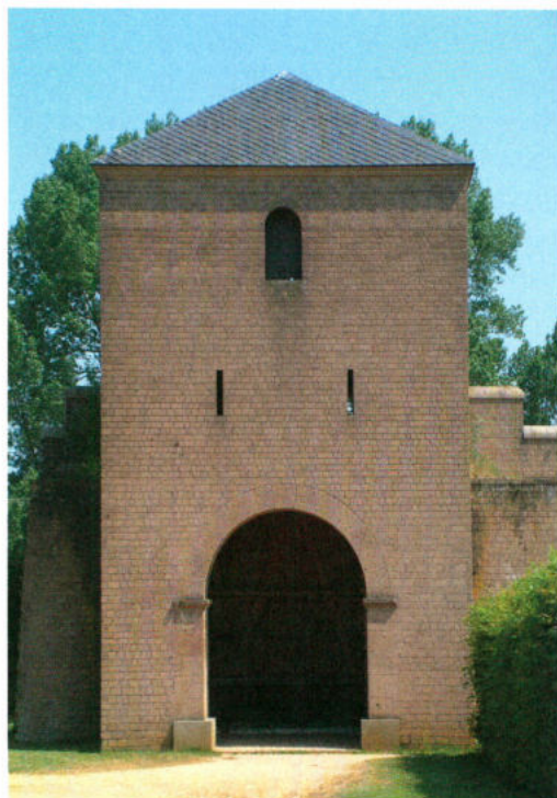
Abb. 6: Rekonstruierter Stadtmauerturm in Xanten mit Tordurchfahrt mit Gewölbesteinen ohne Profilierung. – Reconstructed city gate in Xanten with plain voussoirs.
