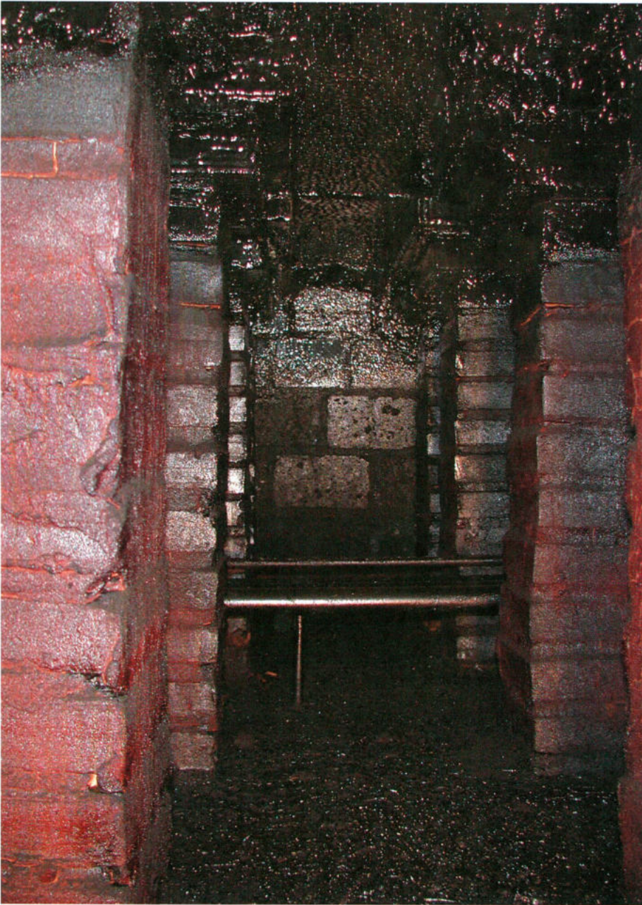
Abb. 10: Schmierruß (oben) und Glanzruß (unten) im hypokaustum unter dem caldarium. – Tarry soot (top) and shining soot (bottom) in the hypocaust under the caldarium.
