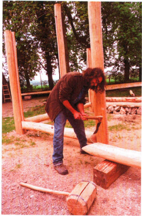
Abb. 5: Die Schwellbalken wurden aus Eichenholz gefertigt und greifen mit V-förmigen Enden in vertikale Schlitzte der Pfosten ein. – The sill beams were made of oak and have V-shaped ends reaching into vertical slots of the post.
