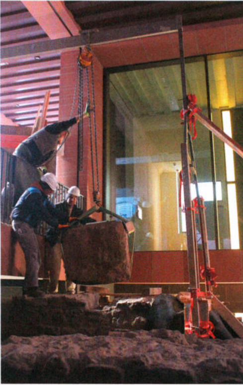
Abb. 8: Wiedereinbringung des „Kühlschranks“ in den spätmittelalterlichen Keller. – Reassembling of the stone-made “fridge” in the late Medieval cellar.
