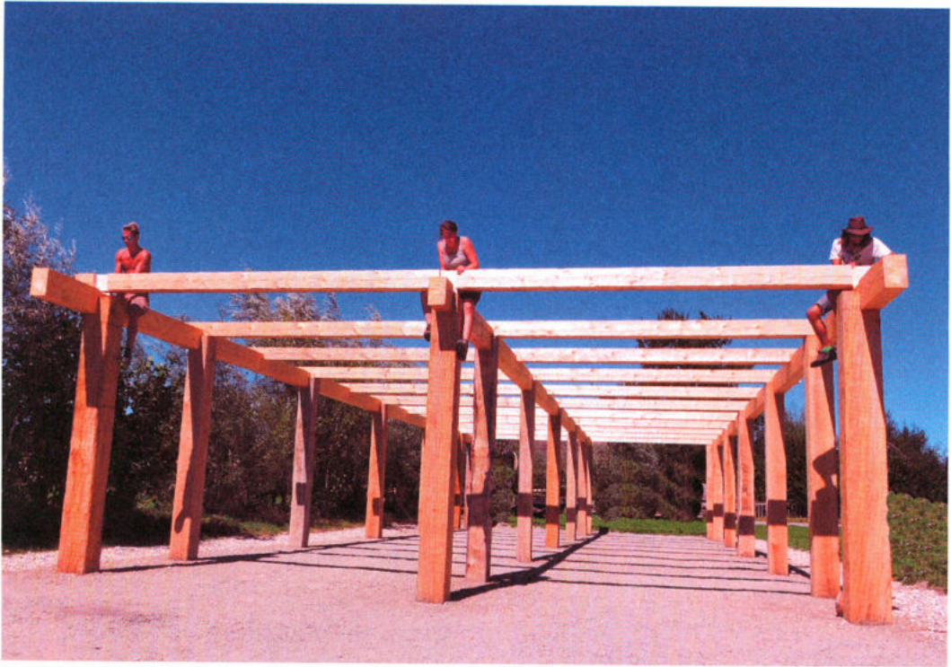
Abb. 9: Der letzte Binderbalken wird in die vorgearbeiteten Lagerfugen eingesetzt. Aus Stabilitätsgründen wurden die Binderbalken aus jeweils einem Stück Holz von mehr als 9 m Länge gearbeitet und verbinden so die drei Pfostenreihen zu einer Einheit. – The last tie beam is positioned. Due to stability each tie beam was made of one single piece of wood with a length of more than nine meters. They connect the three post rows transversally.
