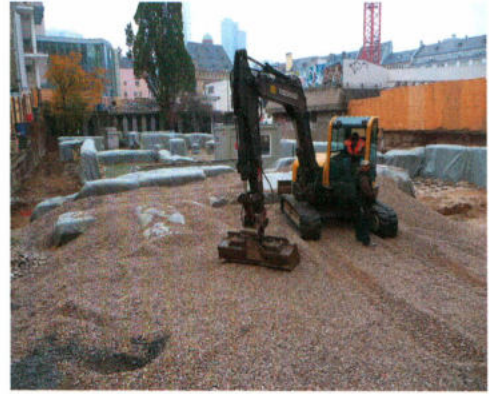
Abb. 5: Auffüllung des Areals zum Schutz der historischen Mauern vor Beginn der Bauarbeiten. – The backfilling of the area to protect the historical masonry before starting the construction works.
