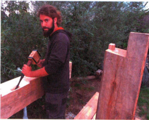
Abb. 7: An den oberen Enden der Eichenpfosten wurden die Auflagen für die quer liegenden Pfetten mit leichtem Gefälle nach innen hin gestaltet. Die Eckpfosten wurden zusätzlich mit Sichtzapfen gesichert. Die Arbeiten dafür erfolgten vor allem mit einem schweren Tüllenmeißel. – On the upper ends of the oak posts we formed sloping notches for the horizontal beams. The edge posts were additionally fixed by tenons. The work was carried out mostly with big socketed chisels.
