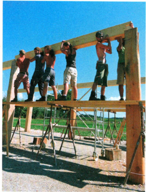
Abb. 8: Sechs Personen waren notwendig, um ein Pfettensegment in die Lagerfugen hochzustemmen. An den breitesten Stellen überbrücken die Pfetten derart bis zu vier Meter Distanz zwischen den Pfostenstellungen. – Six persons were necessary to lift up the segments of the wall plates to their positions. The wall plates bridged gaps of up to four meters in between the earthfast posts.
