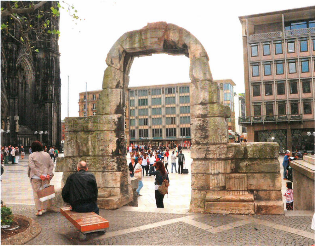
Abb. 7: Reste des römischen Nord-Tores von Köln mit profilierten Gewölbesteinen. – Remains of the Roman North-Gate of Cologne with moulded voussoirs.
