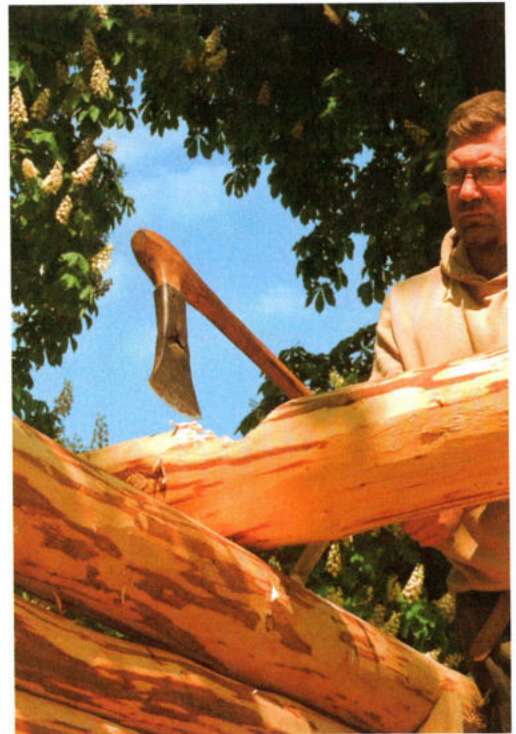
Abb. 7: Tüllenbeile der jüngeren Eisenzeit waren gut geeignet, um halbrunde Ausnehmungen vorzunehmen. – Socketed hatchets of the younger Iron Age turned out to be good implements for carving half round notches.
