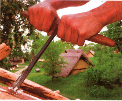
Abb. 8: Aus holztechnischer Sicht bedeutete die Erfindung des Löffelbohrers im Lauf der Eisenzeit eine Revolution im Hausbau, denn nun erst konnten Holznägel im größeren Rahmen eingesetzt werden. – The invention of the spoon drill in Iron Age was a revolution in wood technology and in wooden architecture, because since then wooden nails and pegs could be used in a bigger amount.
