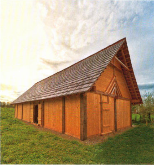
Abb. 14: In den Jahren 2017 und 2018 wurden das Haus und auch die Inneneinrichtung fertig gestellt. Schwellbalken und Türstöcke bestehen dabei aus Eichenholz, Wände, Giebel und Türen aus Fichtenbohlen. – In 2017 and 2018 the house and also the inside furnishings were finished. The sill beams and the door frames were made of oak, the walls, gables and doors were constructed of spruce planks.
