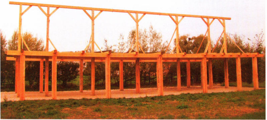
Abb. 11: Die Firstsäulen und auch die Firstpfetten sind aufgesetzt und mit Streben und Holznägeln gesichert. Ansicht des Hallenhauses von Osten. – The crown struts and the apex purlin are set up and were fixed with sloping braces and wooden nails. View of the house from the east.
