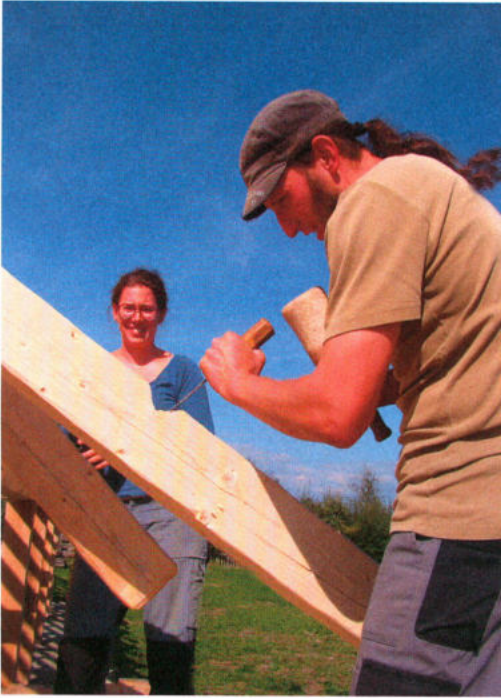
Abb. 12: Unter dem kritischen Blick von Anna Jaklin bemüht sich Christoph Jezek, mit der Stemmbeitelklinge genau der vorgezeichneten Kontur der Markierung zu folgen, denn eine hohe Passgenauigkeit ist letztlich unerlässlich für eine hohe Stabilität. – Christoph Jezek tries hard to follow the marked line with a chisel blade, because a high precision was very important for a high stability.
