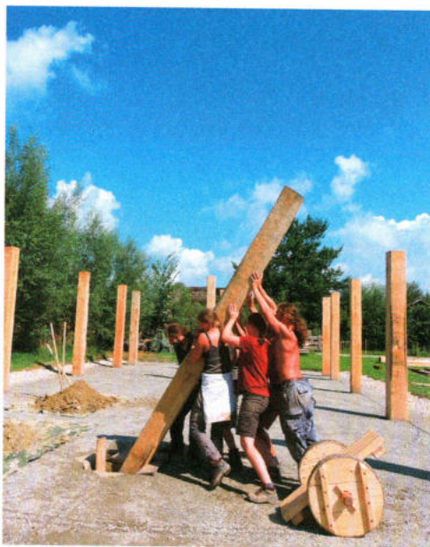
Abb. 6: Mit den vereinten Kräften von sechs Personen gelang es uns, auch die schwersten Eichenpfosten mit Gewichten von bis zu 400 kg aufzurichten; im Vordergrund unser Transportwagen. – With the strength of six persons we managed to erect even the biggest oak posts with estimated weights of about 400 kg; in foreground our transport cart.
