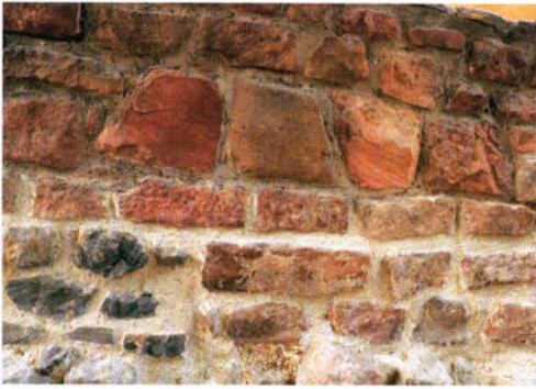
Abb. 6: Im Originalbestand des Mauerwerkes wurde der Zementmörtel (oben) durch kalkgebundenen Restaurierungsmörtel (unten) ersetzt. – The modern cement in the gaps of the historical masonry (above) was replaced by reconstructed mortar (below).
