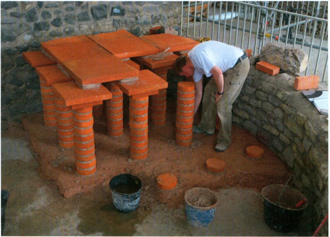
Abb. 7: Aufmauern der rekonstruierten Hypokaustziegel im sudatorium des römischen Bades. – Bricking up the reconstructed tiles in the sudatorium of the roman bath.
