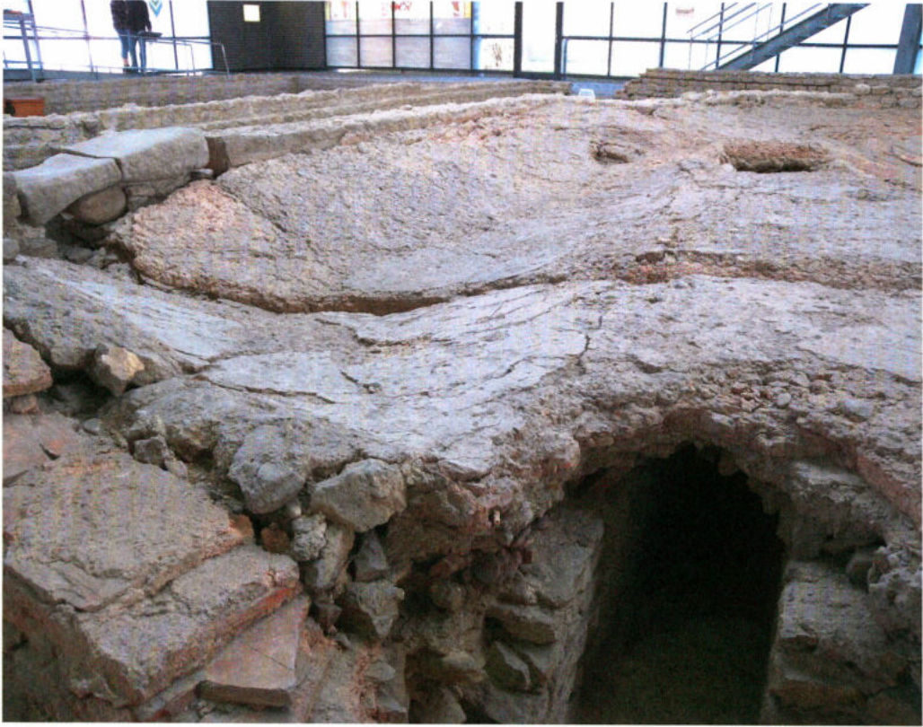
Abb. 6: Wellenförmig verformter Boden in den Kleinen Thermen von Cambodunum. – Wave-like distorted floor in the Kleinen Thermen von Cambodunum.
